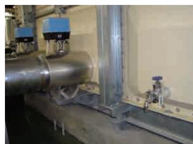
▲緊急遮断弁と給水栓の設置
