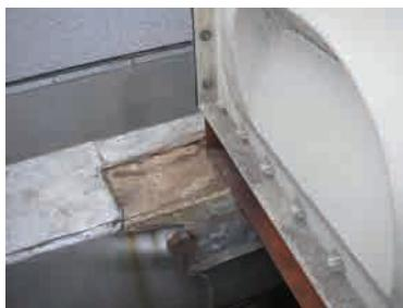
▲コンクリート基礎から貯水槽と架台が移動
