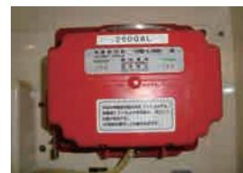
▲緊急遮断弁感知器の設置
