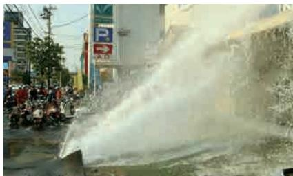
◀老朽化が原因で水道本管が破裂。大量の上水が流れ出る。
