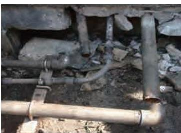
▲水道配管の破壊
