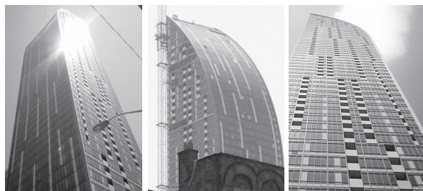
写真1 壁と屋根の一体性
