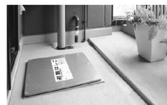
写真-1：バルコニー避難ハッチ
