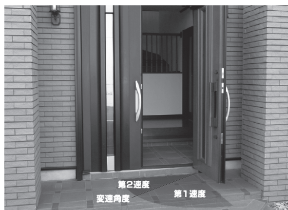
図2 ドアの開閉速度、変速角度の調整
