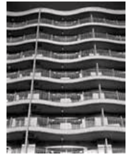
バルコニーに格子タイプの墜落防止手すりか設置された外構例
