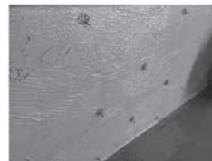
施工写真: 常温アスファルト防水
